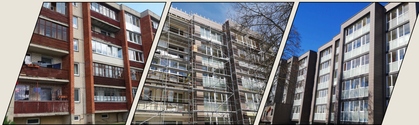
Daugiabutis namas iki renovacijos Daugiabutis namas renovacijos metu Daugiabutis namas po renovacijos
